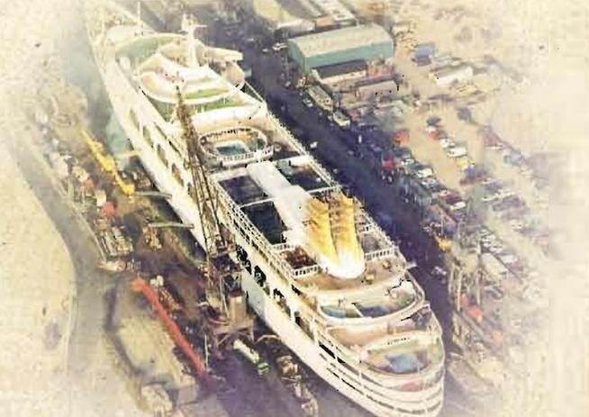
установка, подобно «Нормандии», построенной на 25 лет раньше, была турбоэлектрической. Спасательные шлюпки расположили в нишах корпуса, ближе к ватерлинии, а значительную часть надстройки изготовили из алюминия, облегчив вес судна, что привело к уменьшению расхода топлива.
